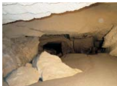
Interventi di consolidamento cavità sotterranee
